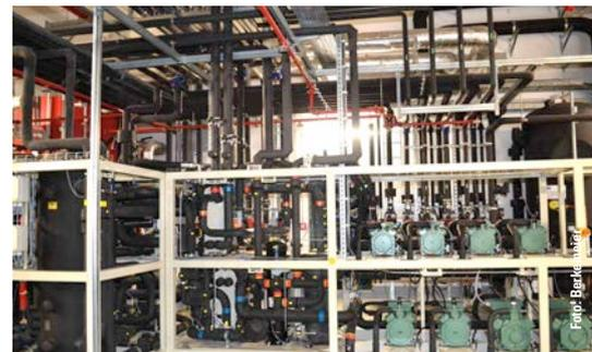
**Die Kälteanlage des Komplexes wird mit dem natürlichen Kältemittel CO<sub>2</sub> betrieben. Außerdem wird die Abwärme genutzt. Nur zwei Beispiele im neuen Lager für nachhaltiges Wirtschaften.**
