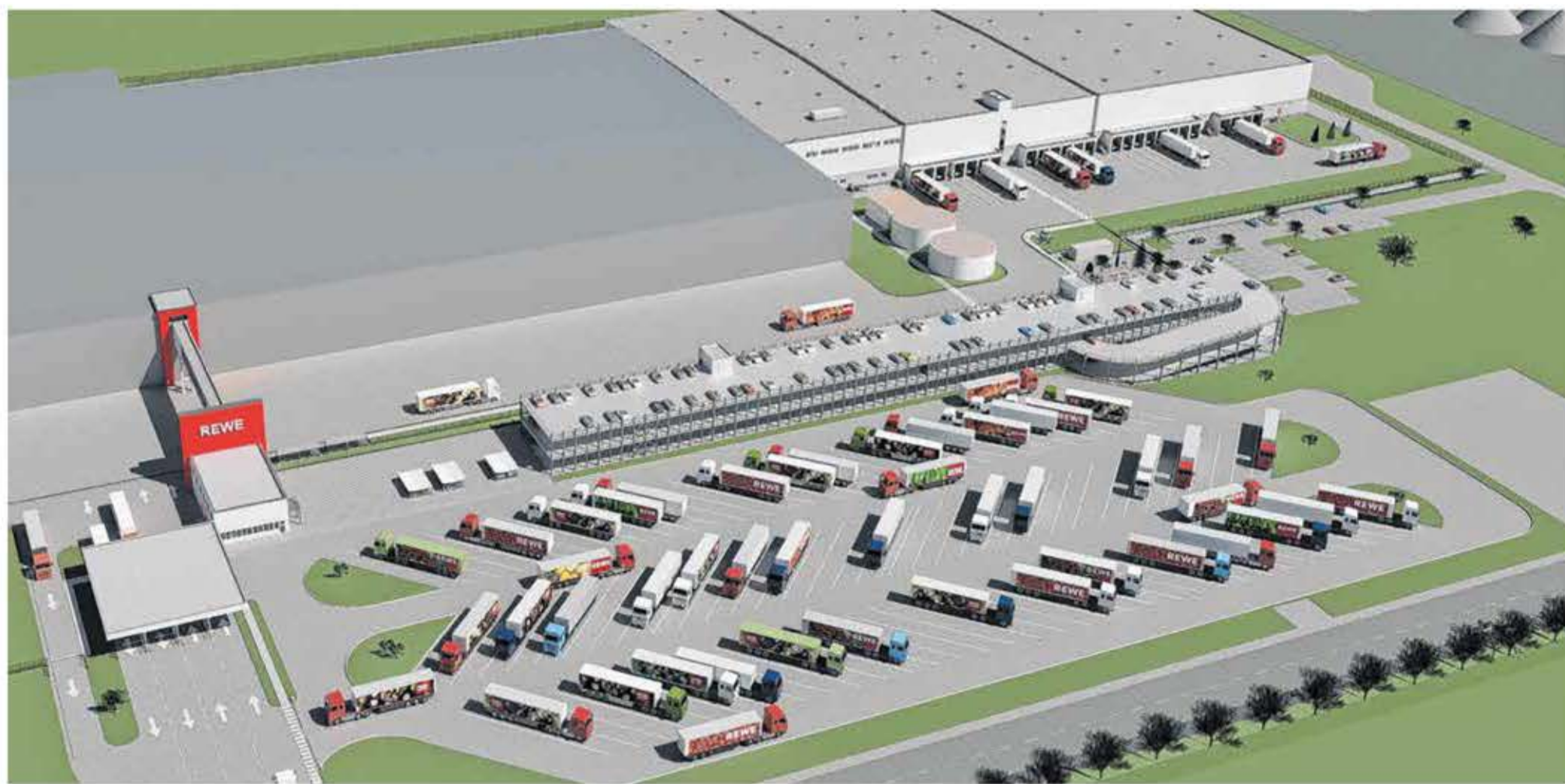
Anbau: Die neue Lagerhalle entsteht nördlich des bestehenden Lagers (rechts). Stellplätze für Lkw werden östlich des Grundstücks geschaffen (vorn). Bild: Thiele und Linnenberg
